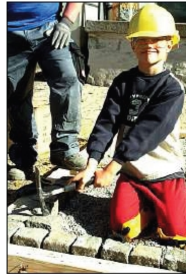
Pflastersteine verlegen, das konnten die Kinder nach kurzer Zeit schon selber machen.
